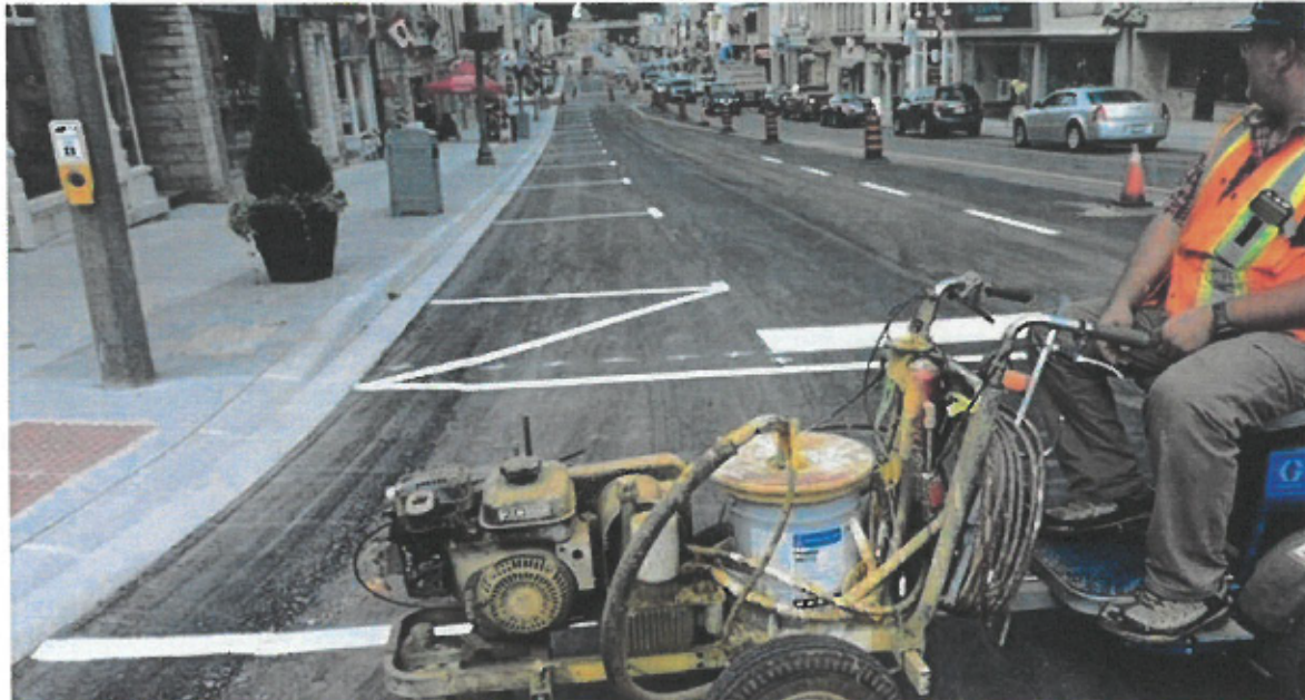
Figura 8. Trasarea marcajelor de delimitare a parcarilor
