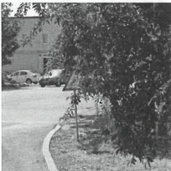
Fig 12k. Marcaje orizontale acoperite de vegetație. Strada Mioriței. Sursă: Google Maps
