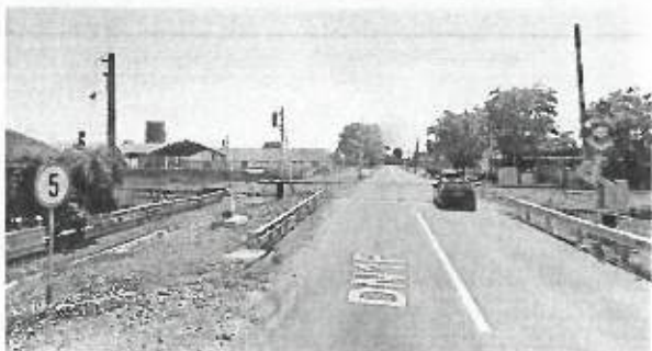
Fig. 10f. Marcaje rutiere verticale. Strada 1 Decembrie 1918. Sursă: Google Maps
