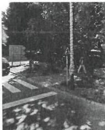
Fig. 13d. Marcaje verticale treceri pietoni. Strada Uzinei. Sursă: Google Maps
